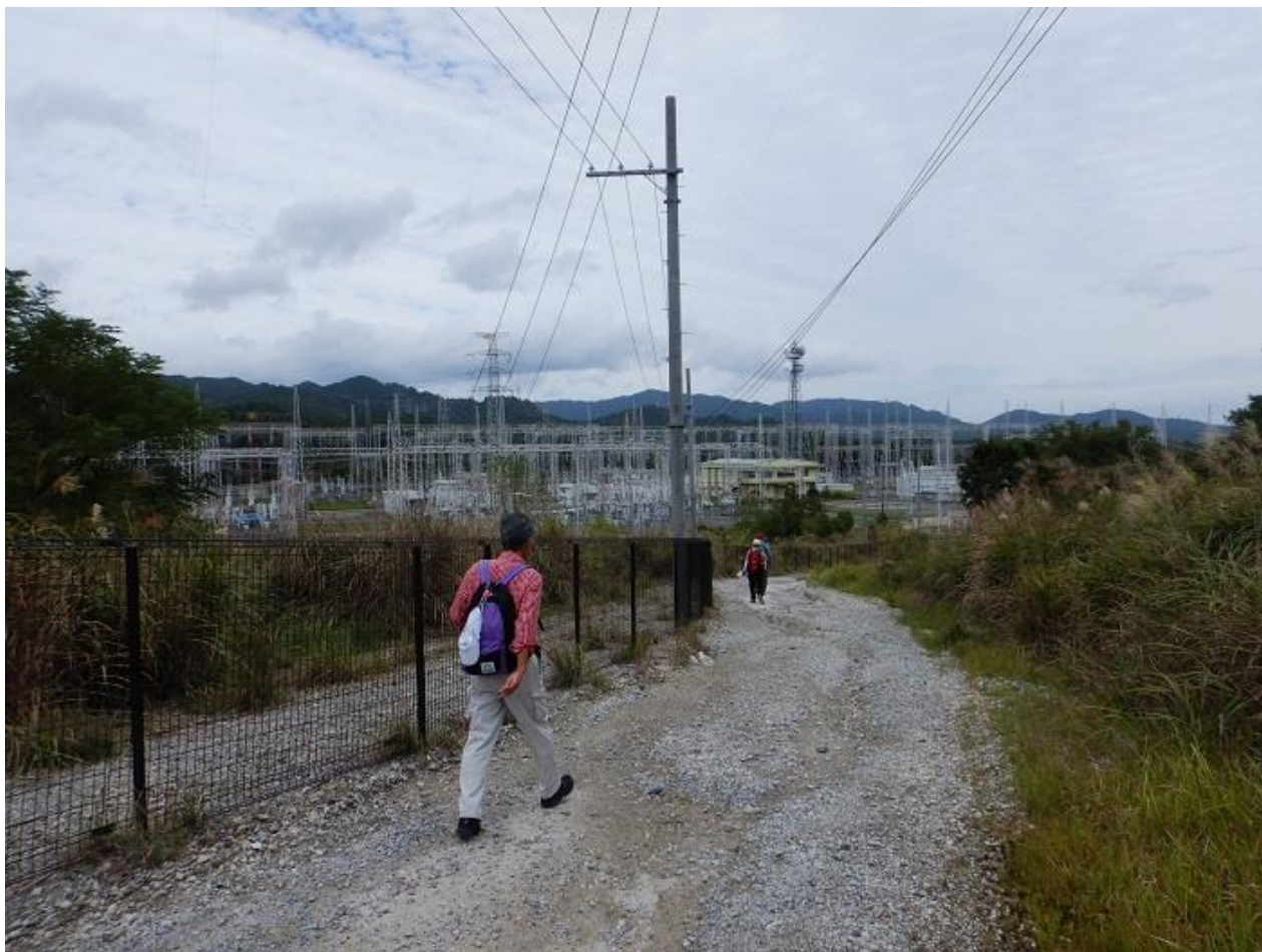
19, 変電所はもうそこ
