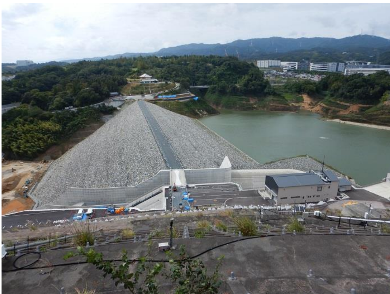
14, オプションで 2022 年完成の安威川ダムを見に少し下る
