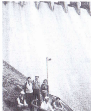
昭和初期完成の千刈ダム
